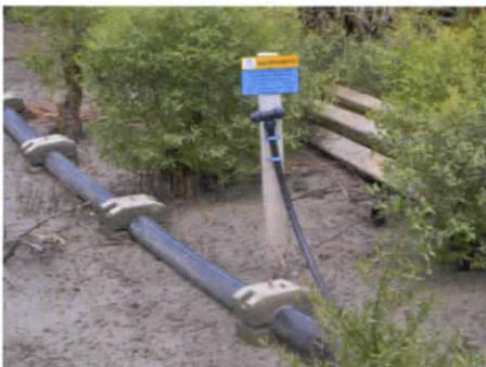
พื้นดินเช่นปกติ แต่ใช้วิธีการวางท่อแบบ HDPE counter weight (การถ่วงท่อ HDPE ลงในน้ำ) และทุก ๆ เดือน เจ้าหน้าที่อ่านน้ำของ กปน. จะลงเรือเข้าไปอ่านน้ำและนำใบแจ้งค่าน้ำส่งให้แก่ผู้ใช้น้ำถึงบ้าน โดยในปัจจุบันมีการติดตั้งมาตรวัดน้ำเพื่อบริการประชาชนที่อาศัยอยู่ริมน้ำในบริเวณดังกล่าวแล้วประมาณ 40 กว่าครัวเรือน และยังมี การขอติดตั้งมาตรวัดน้ำในพื้นที่เพิ่มขึ้นอย่างต่อเนื่อง
