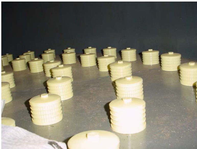
ภาพที่ 3 แสดงการวางหัวกรองน้ำประเภท Nozzles บนแผ่น Plate
