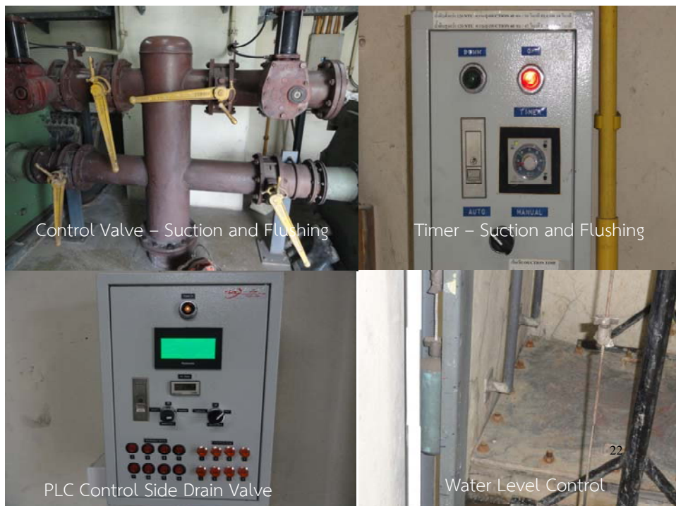
รูปที่ 4 แสดงอุปกรณ์ในการควบคุมการทำงานของถังตกตะกอน Pulsator และ Lamellae pulsator
