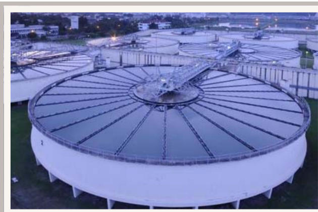
ถังตกตะกอนของโรงงานผลิตน้ำบางเขน การประปานครหลวง
